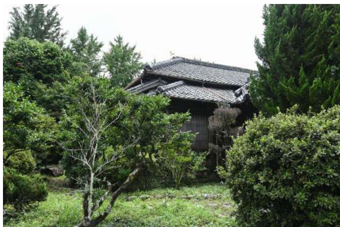
W家建物。昭和初期に建設された住宅で、資料保全後に解体された。〈開発に伴う緊急調査〉の考え方で行ったレスキュー活動。
