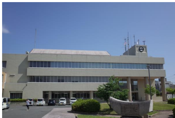
参考：倉敷市真備支所（2020年6月）
